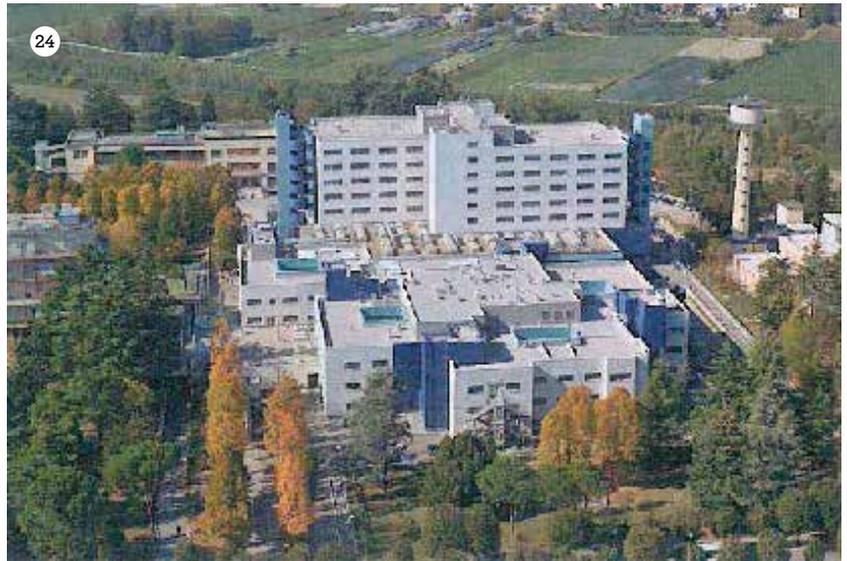
cinto (SJ) - potesse resistere ad almeno due volte il livello di intensità sismica indicato dall'UBC (Uniform Building Code), restando operativo anche nel corso del più forte terremoto che fosse potuto accadere.
