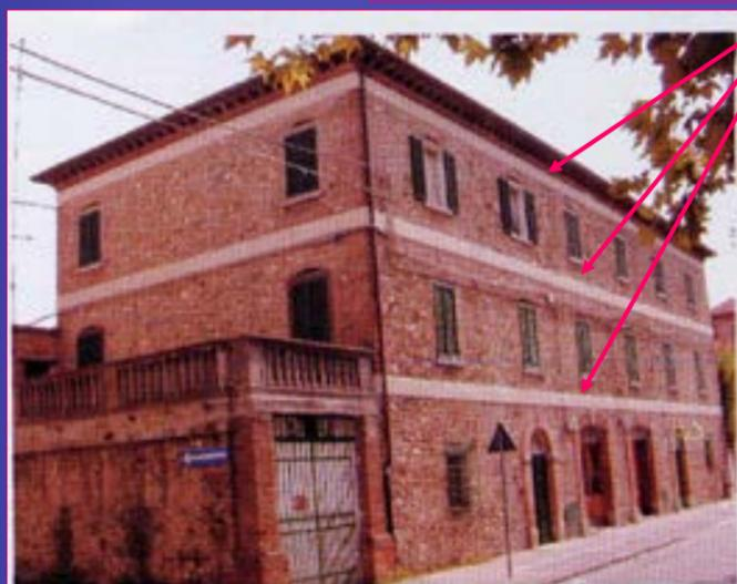
Fig. 3 - Incatenamento realizzato con compositi
